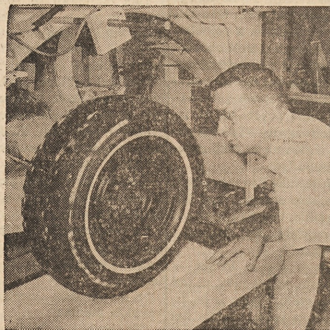
PRESKUŠANJE GUM — Avtomobilsko gumo na sliki prekušajo na "ledeni cesti" v delavnicah B. F. Goodrich v pogledu trpežnosti in varnosti "vožnje".
