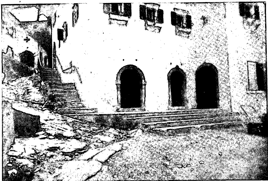
Sl. 10. Petrač (h. št. 12). — Vrata v kleti (spodaj) in vhod v stanovanje po stopnicah (levo); na oknih požarne oknice
