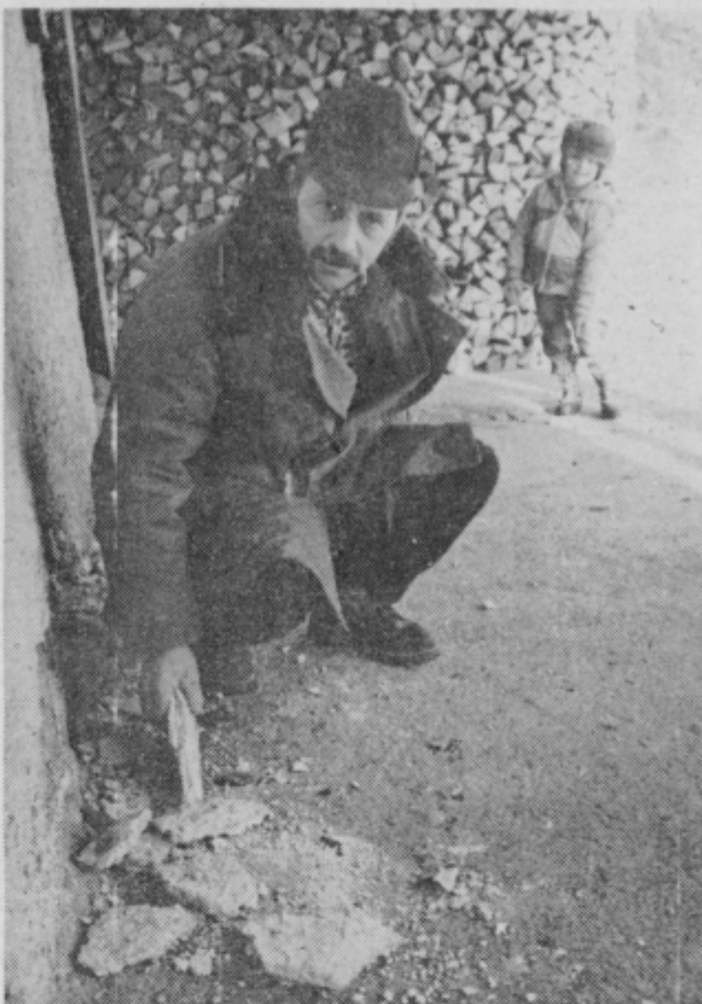
Jože Pečnik kaže, kje je začela zemlja od spodaj pritiskati na temelje in zidove
