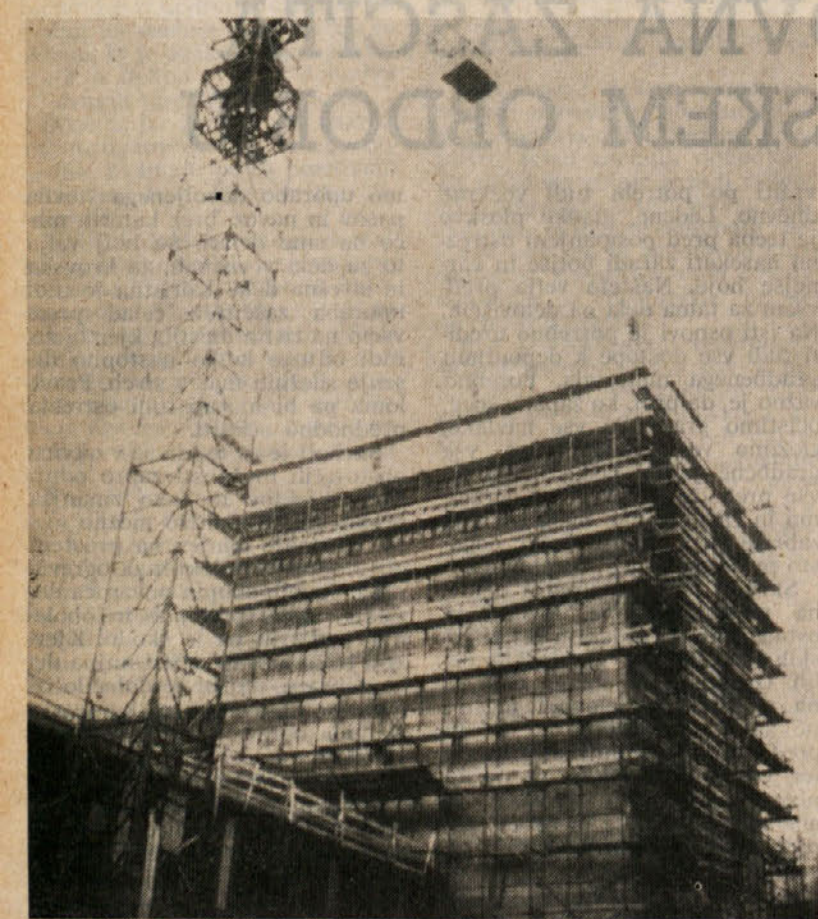
Pogled z gradbiščne ceste na silos. V ospredju vidimo stolp našega žerjava, Weitzla, ki je podaljšan do maksimalne višine (40 m), pri kateri je še dovoljena vožnja po tiru. Poseben problem je predstavljala potreba velike količine cevnega odra. Podjetje je moralo za to gradnjo nabaviti preko 3.000 m 2 novega cevnega odra.
