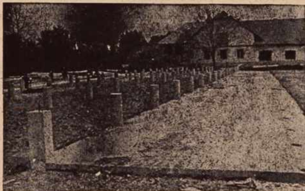
Začetna dela pri gradnji hlevov v Veržeu
