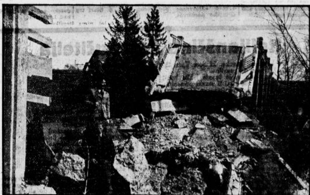
Porušeni most na cesti Škofja Loka — kolodvor.
