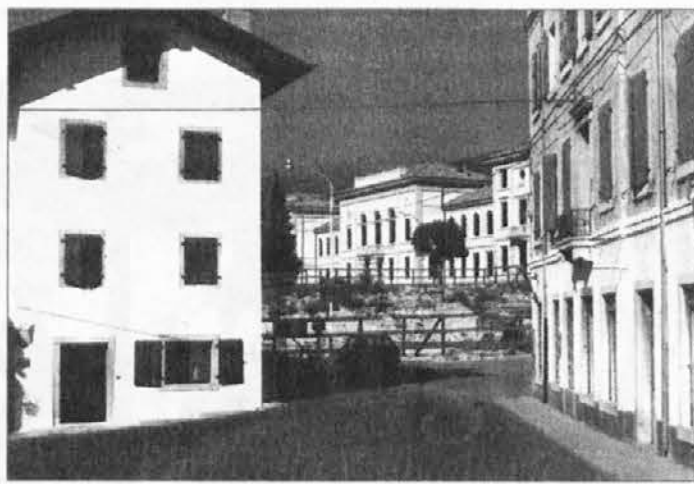
La curva a nord di S. Pietro dove inizieranno i lavori di rettifica
