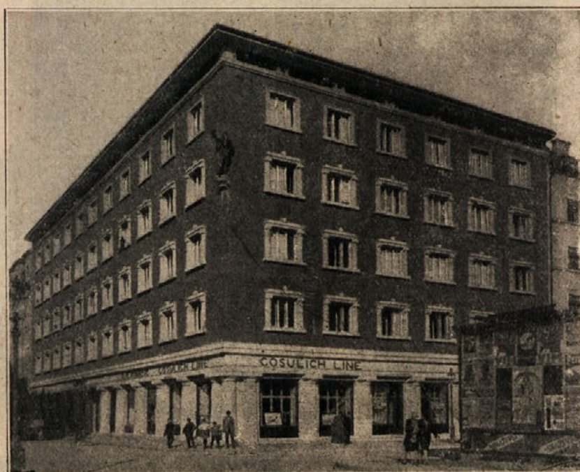
Stanovanjska hiša Pokojninskega zavoda na oglu Miklošičeve ceste in Pražákove ulice.
