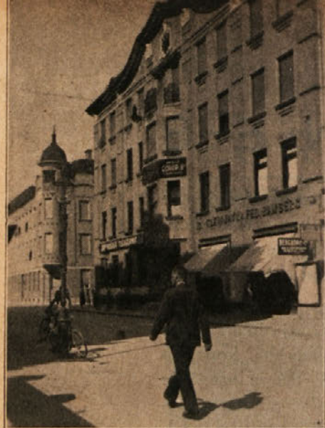
Palača na Miklošičevi cesti 16, kjer so v I. nadstropju nastanjeni poslovni prostori.
