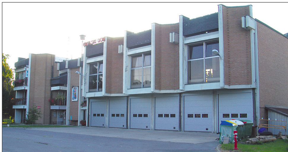
Objekt gasilskega doma Ptuj, ki je bil zgrajen leta 1978, naj bi v kratkem v celoti obnovili in celo dogradili.
