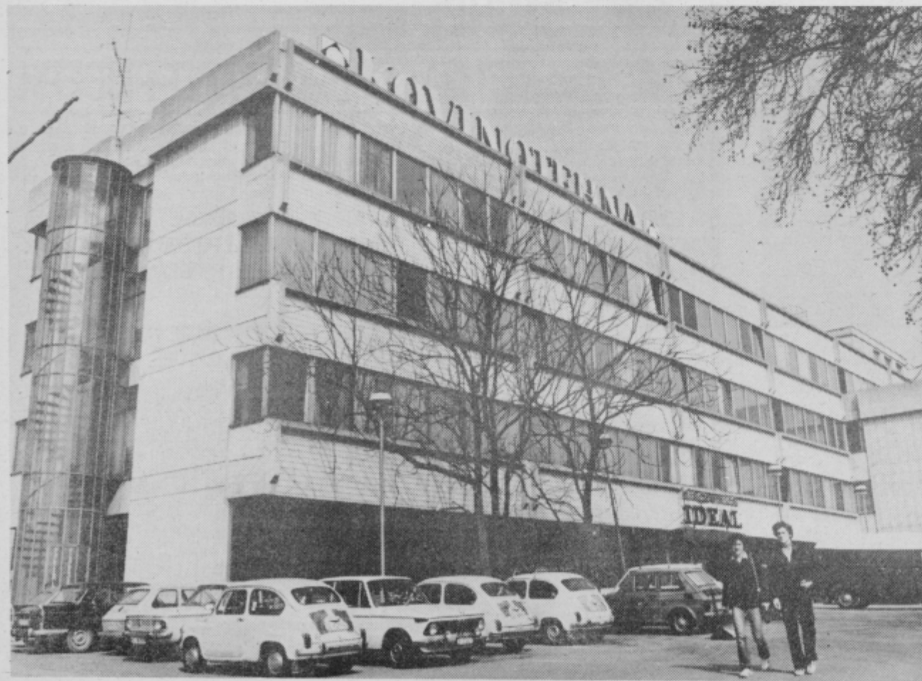
V tej stavbi Kovinotehne je tudi Center za drobno gospodarstvo.
