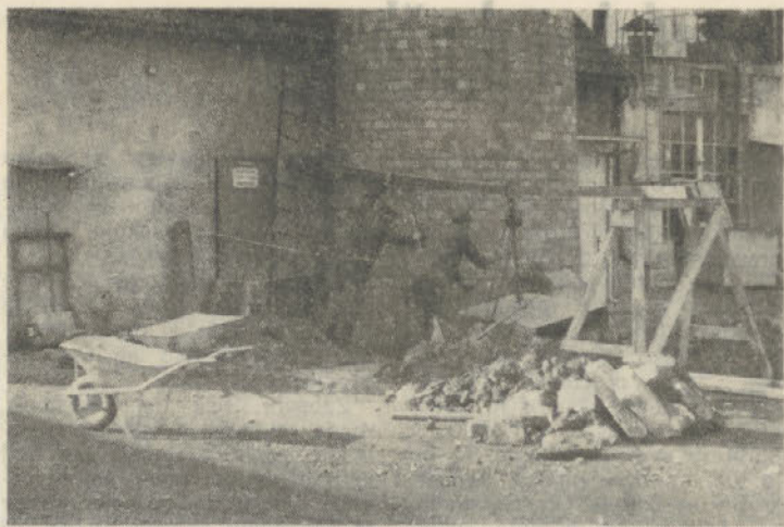
Tudi pri takšnih gradbenih delih, bi semorala upoštevati navodila za varno delo!
