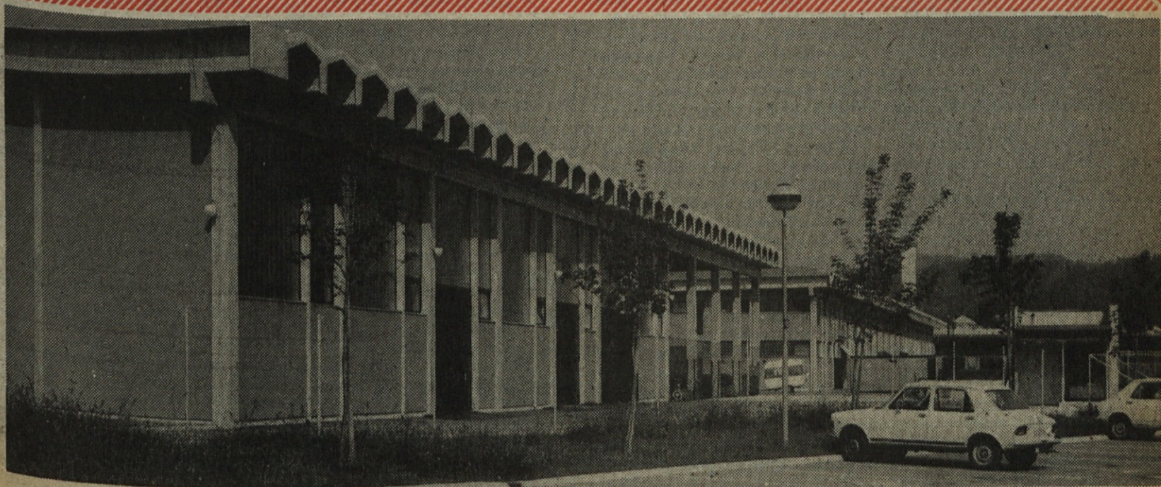
Gradisove montažne hale z y nosilci rastejo po Sloveniji kot gobe po dežju
