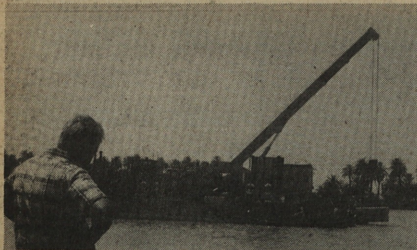
Odlaganje sidrov v Tigrisu za vezanje pontonskega sestava
