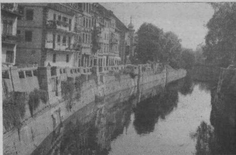
Nad 60 let so stari zidovi ob Ljubljani. Čas, zmrzal in vegetacija so jih močneje poškodovali. Zato so se na Območni vodni skupnosti Ljubljana-Sava odločili, da jih obnovijo.
