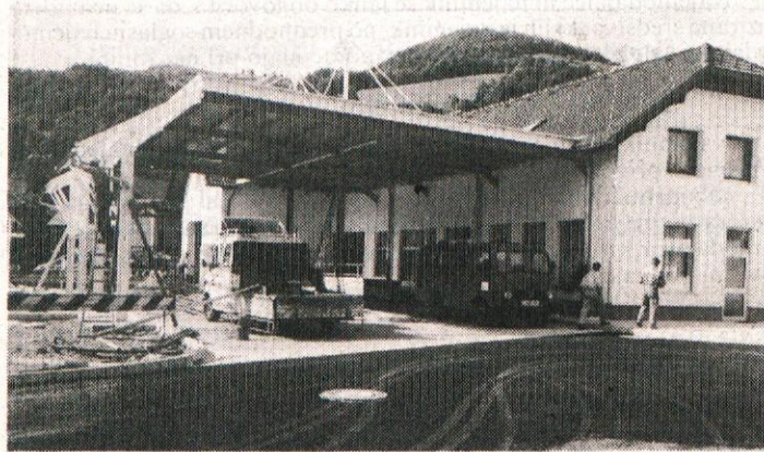
ZAKLJUČNA DELA NA BENCINSKI ČRPALKI V HORJULU - Te dni asfaltirajo dovozne poti, urejajo okolico in pripravljajo podrtovke za montažo črpalk za gorivo. Približuje se tudi tehnični prevzem objekta in Horjulci upamo, da bomo za dan državnosti že napajali svoje je-klene konjičke na novi Lončarjevi bencinski črpalke. (F.B.)
