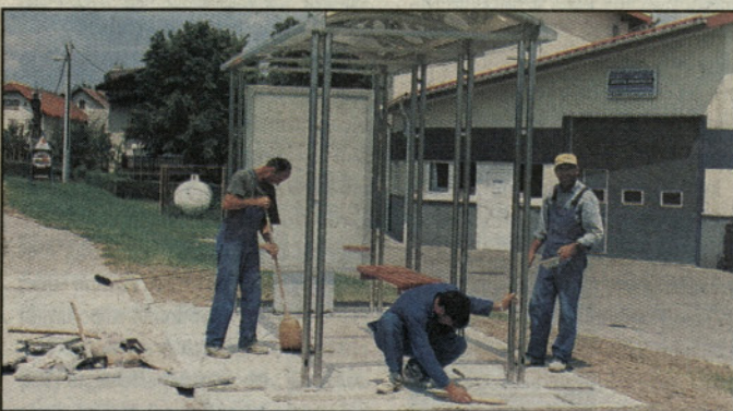
Postavljanje novega avtobusnega postajališča v Ločici ob Savinji.
