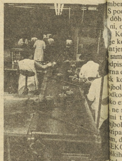
Linija za proizvodnjo statorjev kompresorskega motorja.
