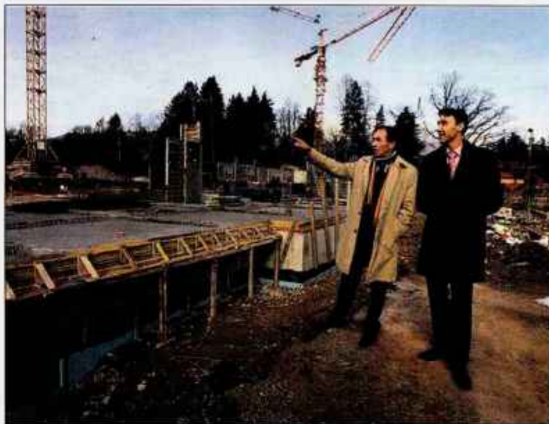
Iztok Purič (levo) in Franci Kodela na gradbišču konferenčnega centra EU. / Foto: Tina Dolič
