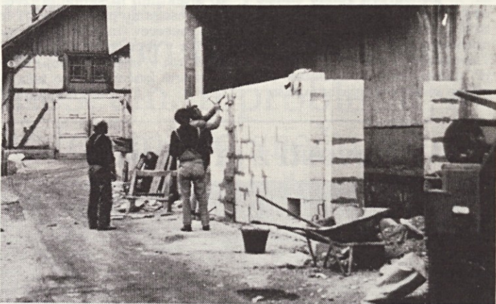
Agregat za zasilno razsvetljavo smo zaradi novega prizidka predilnice v decembru prestavili v nov prostor. Na sliki: delavci gradbenega podjetja med gradnjo novega prostora
