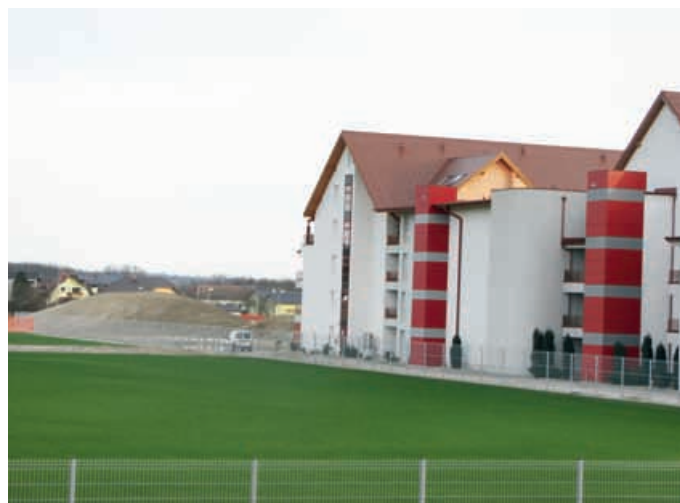
VADBENI IN ŠPORTNI CENTER – Na severni strani depandanse hotela Vivat v Moravskih Toplicah nastaja nov vadbni in športni center. Za ogrevanje terena je uporabljena odpadna topla voda iz zdravilišnega sistema.
