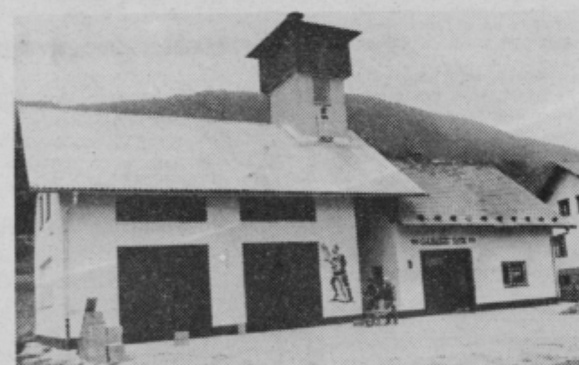
Gasilci so temeljito obnovili svoj dom.
