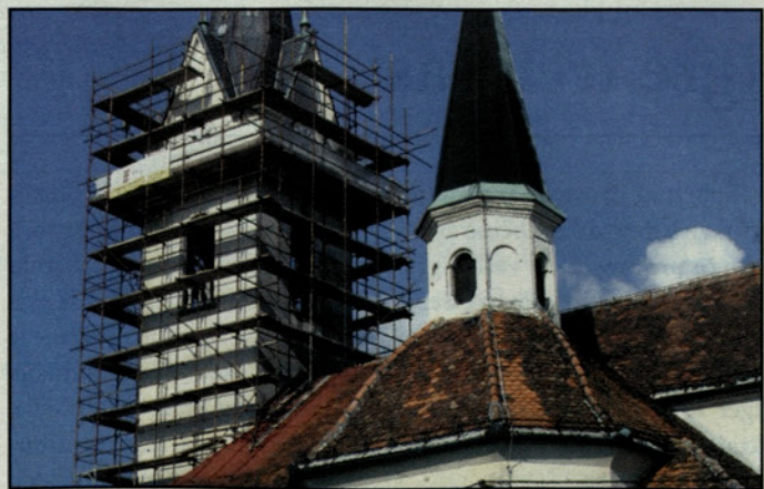
Pri obnovi zvonika
