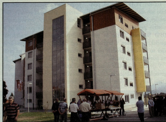
Nov stanovanjski blok na Polzeli
