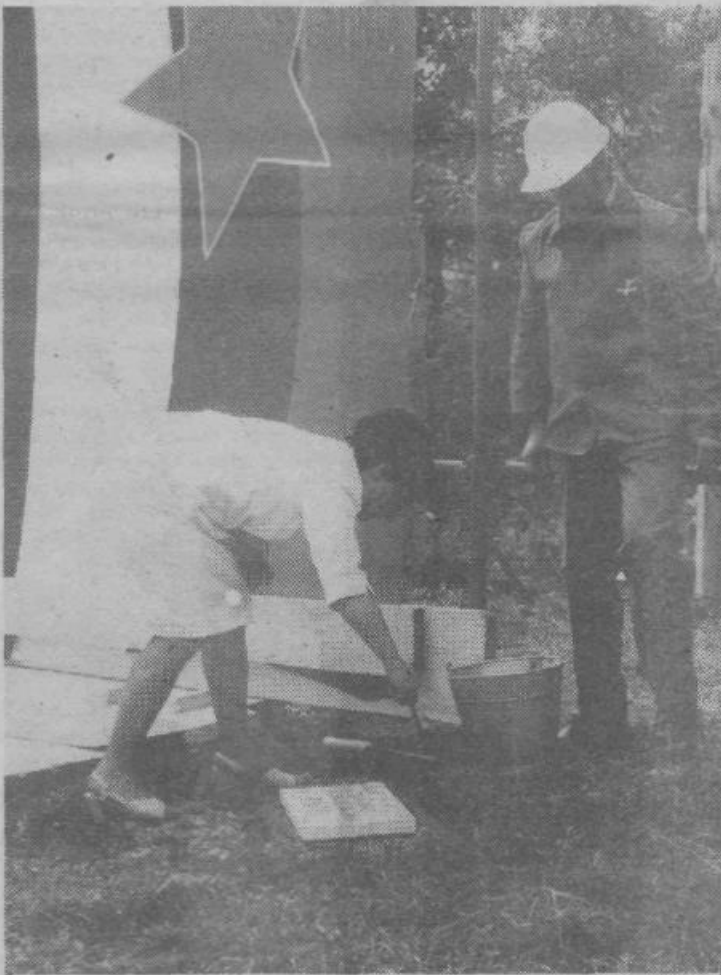
Prizidek za otroški dispanzer pri zdravstvenem domu Moste. Dne 22. septembra 1978 je bil položen temeljni kamen zanj, predvidena investicijska vrednost je 18.560.000 — foto TOM
