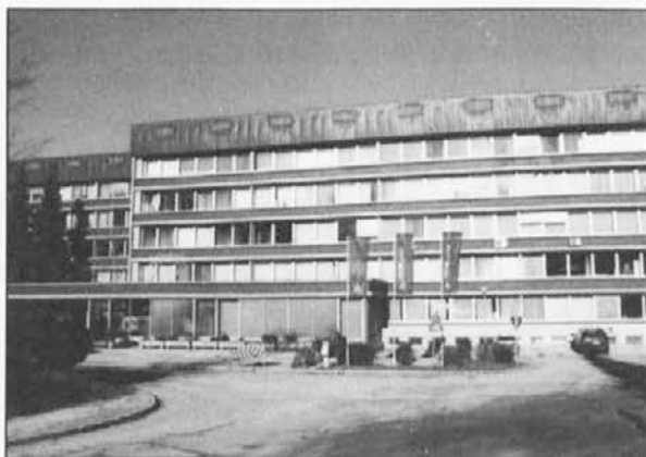
Poslovna zgradba Metala Ravne
