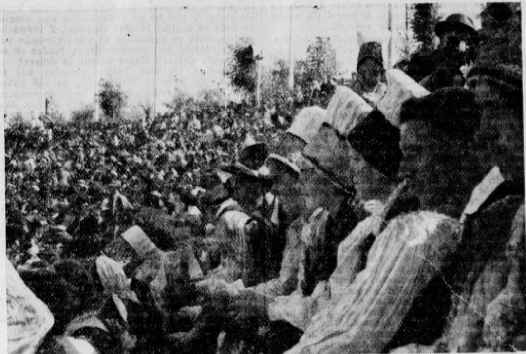
Pogled na Stadion na desni strani tribune
