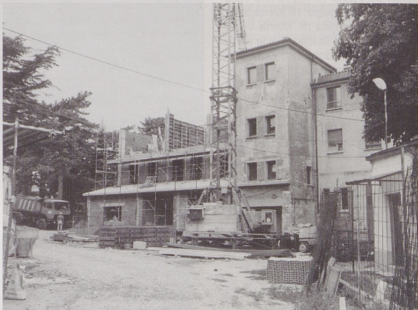
Stavba Marijanišča na posnetku v jeseni 1995, ko še ni bila pod streho.
