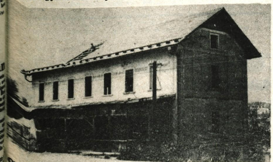
Obnova Rodice – Po potresu, ki je prizadel tudi Bohinj in Bohinjsko Bistrico, je bila Rodica, stavba poleg železniške postaje v Bohinjski Bistrici, dolgo časa zapuščen in nujno potrebna obnove. Nanjo so poskušali delegati v skupštinskih klopih in letošnje poletje so jo dokončno zabetali obnavljati. Rodico naj bi temeljito obnovili, železniško postajo pa naj bi jo namenili potrebam zimskega turizma na Gorenjskem. Foto: D. Sedej
