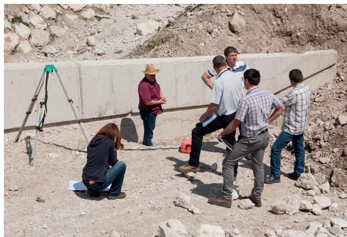
Na gradbišču. Nordijski center Planica, Rateče, 2014
