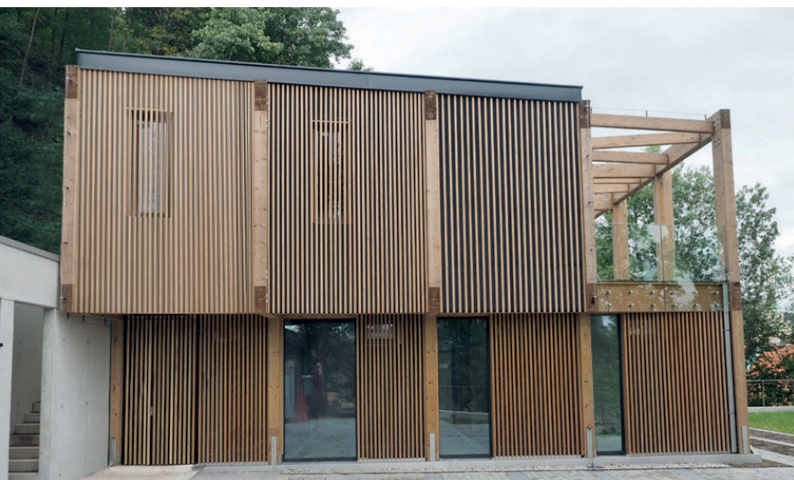
Upravni objekt Javnega zavoda Ljubljanski grad, Na Stolbi 8, Ljubljana, 2021 (samostojno delo)
