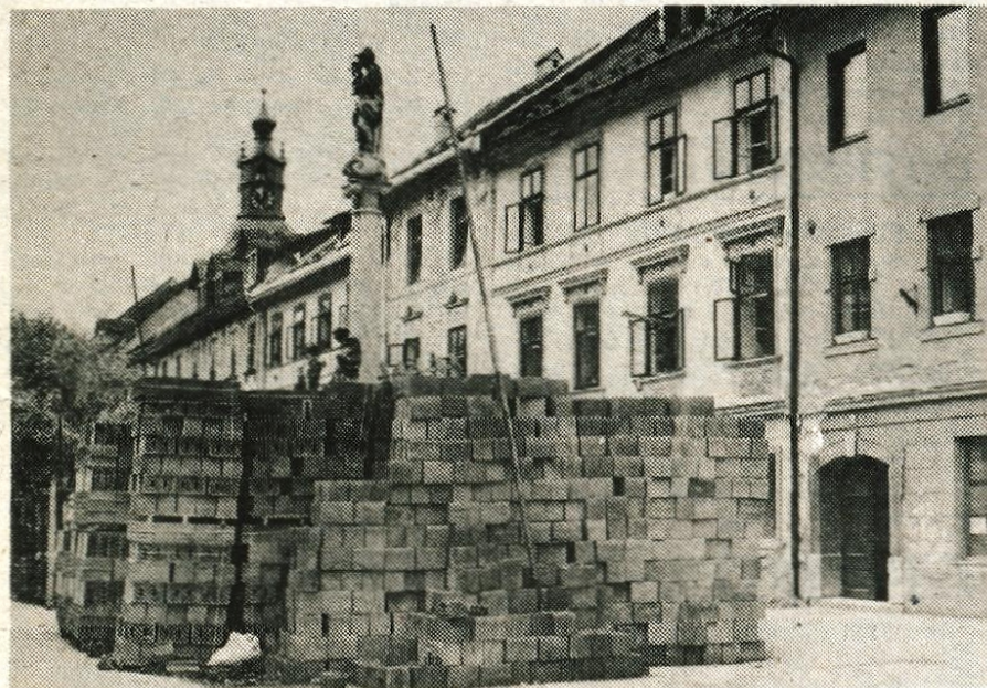
V turistični sezoni tako ne sme biti. — Na Mestnem trgu v Škofji Loki se je ta leta že veliko gradilo, a graditelji so material sproti dovažali. Zdaj pa je tu pravo skladišče materiala — Foto: F. Perdan
