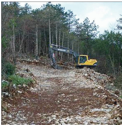
Slika 1: Postavljanje opozorilnih tabel, gradnja in vzdrževanje protipožarnih presek ter zidov je v celoti financirano iz državnega proračuna.
