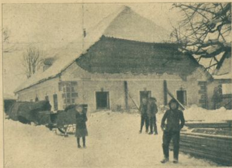
Potres na Dolenjskem. Hiša župana Ajstra v Krški vasi. Na sliki se vidi od potresa izbit požarni zid, ostala stena je z opornimi stebri podprta, odprtina pa zadelana z deskami. To delo so opravili pionirji. Notranjost hiše je vsa razsuta in so vse stene in stropi podprti z opornim stebrom.
