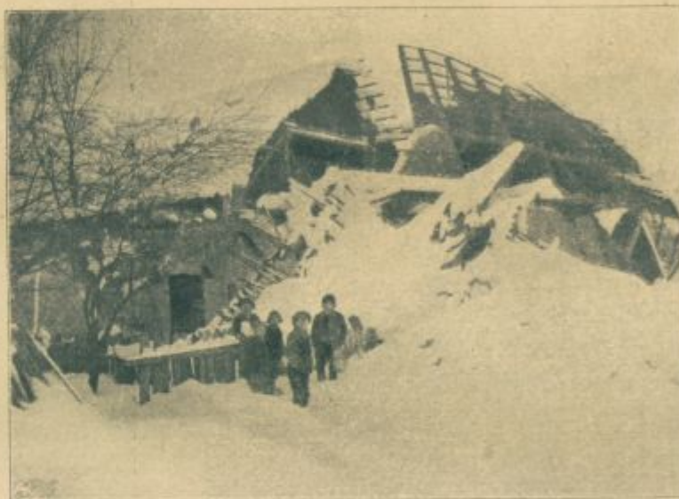
Potres na Dolenjskem. Hiša Janeza Ivšiča iz Krške vasi št. 21 je popolnoma razsuta. Ko se je hiša porušila, je ubila in pokopala troje goved in posula Ivšičevega sina, ki so ga težko poškodovanega s težavo rešili izpod grobelj.
