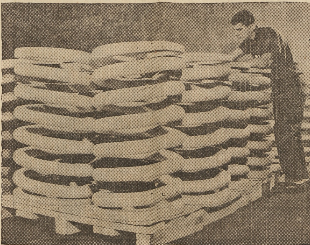
MOGOČNE VZMETI — Mlad strokovnjak si ogleduje v Chicago Heights, Ill., vzmeti, ki služijo za oporo medcelinskim raketam v podzemskih silosih.
