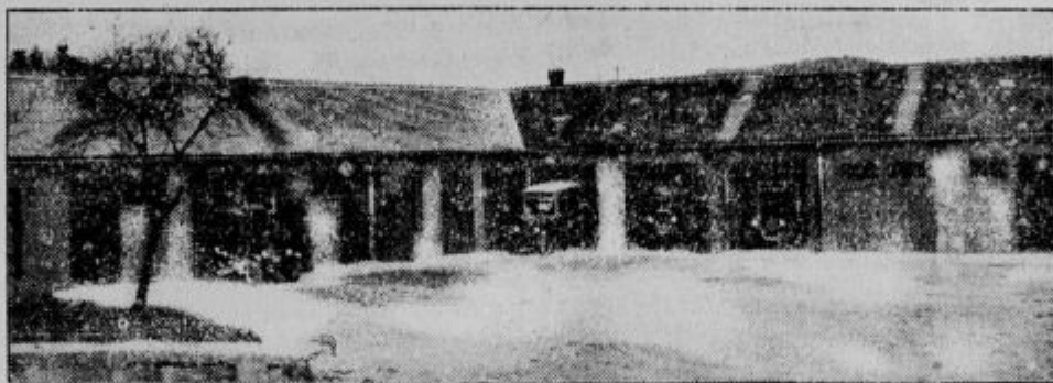
Stavba avtoprometa mariborske občine.
