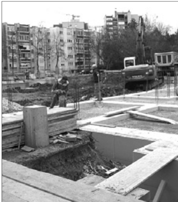
Na gradbišču ob Cankarjevi ulici
