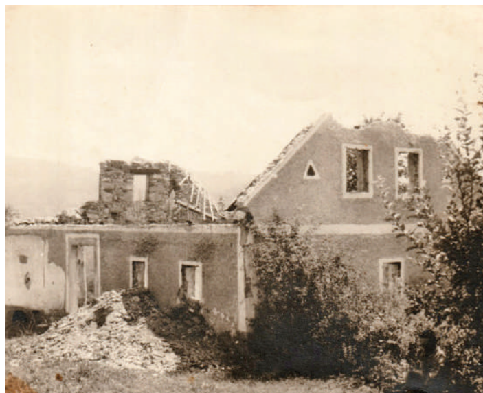
Požgana Koroščeva hiša v Obršah
