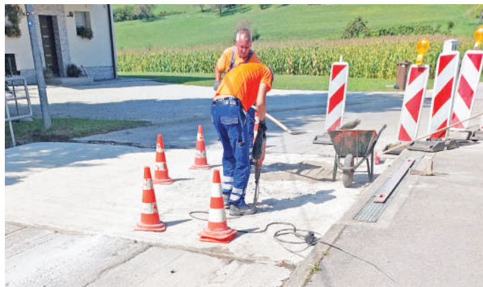
Sanacija propusta Rafolče
