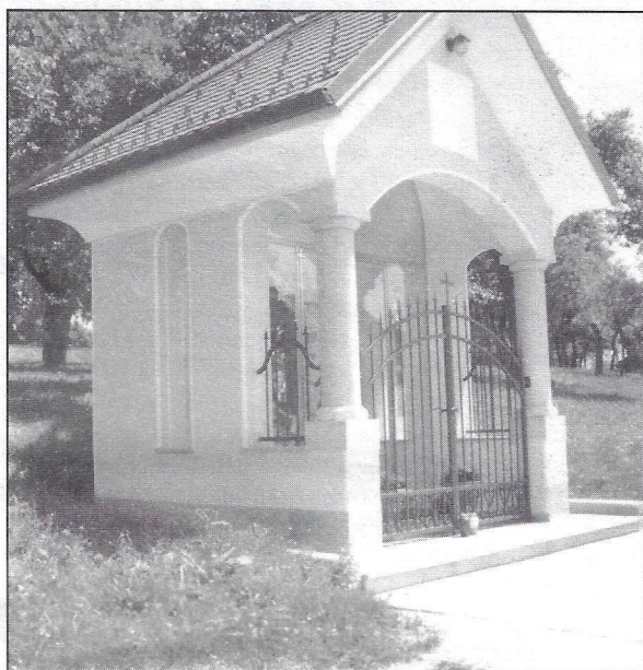
Na novo postavljena kapela v Velikih Lesah
