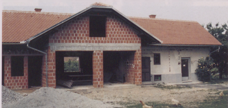
Obnova gospodarskega poslopja
