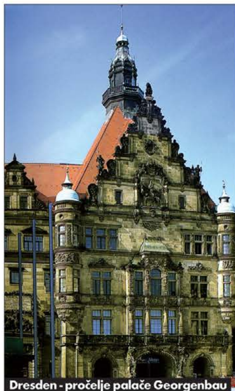
Dresden - pročelje palače Georgenbau
