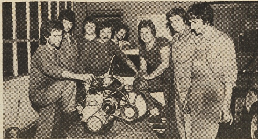
Fantje na gornjem posnetku so avtomehaniki na Zastava servisu v Novi Gorici. Ob mojem prihodu na servis so se zbrali okrog motorja za Zastavo 750 (fičko), na katerem je majhna sprememba. Namesto običajne diname, ki je vgrajena na vse dosedanje motorje v fičkotih, je na gornjem motorju vgrajen alternator AAG. V razvojnem oddelku Iskre - Avtoelektrike namreč pripravljajo in preizkušajo spremembo, da bi namesto diname DCD vgrajevali na motorje omenjene alternatorje.
