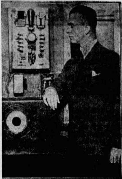
Der Leiter der Berliner Versuchsstelle für Fernmeldewesen der Polizei, Polizeihauptmann Dr. R i s s o w, hat einen Radioweder konstruiert, der an jede Funkanlage angeschlossen werden kann. Der Vorteil dieser sehr wichtigen Erfindung liegt darin, daß sie den Funken einer Empfangsstation an den Apparat ruft, d. h. daß der Junker — ohne ständig am Apparat sitzen zu müssen — doch alle Sendungen aufnehmen kann. — Unsere Aufnahme zeigt den Erfinder mit seinem Radioweder.
