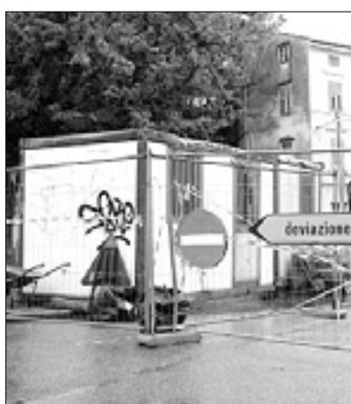
Gradbišče je danes pred cerkvijo
