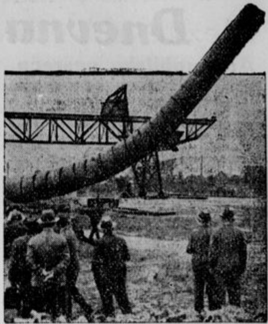
Dimnik se zvija. Pri neki stari plinarni v Berlinu so porušili visok dimnik. Dočim so običajno dimniki, katerim razstrelje temelje, zrušijo na tla in se med padcem navadno prelomijo na dva ali tri dolge kose, se je ta dimnik zdrobil na celo vrsto obročev, tako da se je med padanjem že čudovito zvijal.
