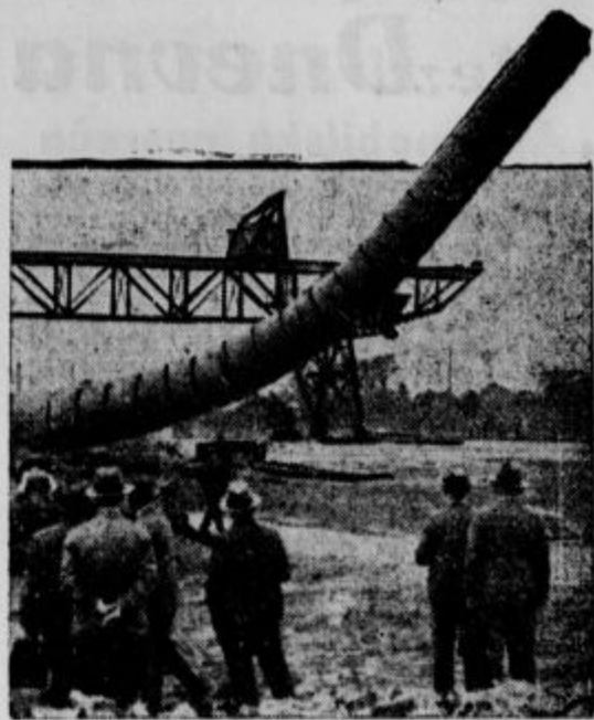
Dimnik se zvija. Pri neki stari plinarni v Berlinu so porušili visok dimnik. Dočim so običajno dimniki, katerim razstrele temelje, zrušijo na tla in se med padcem navadno prelomijo na dva ali tri dolge kose, se je ta dimnik zdrobil na celo vrsto obročev, tako da se je med padanjem že čudovito zvijal.
