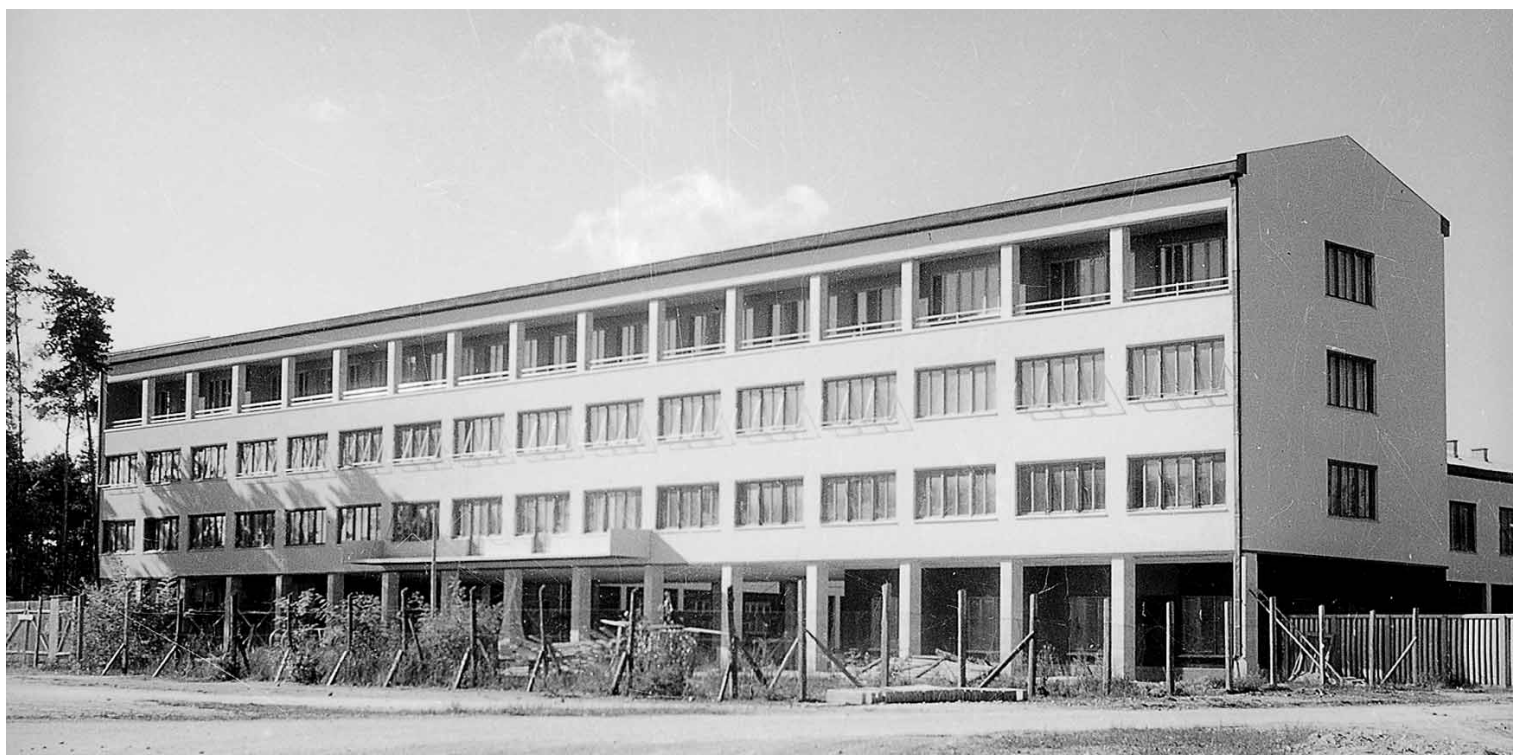
Novo zgrajena upravna zgradba
