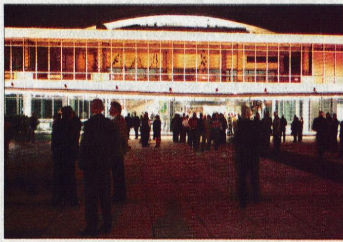
Prenovljena hala A bo poleg sejmov služila kongresni dejavnosti in ostalim prireditvam.
