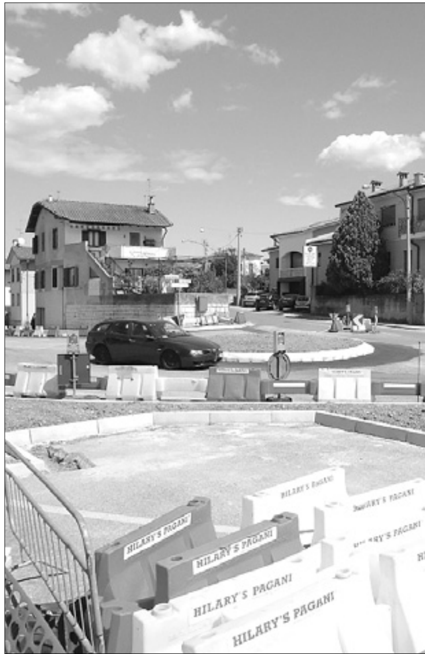
Nedokončano štandreško krožišče
