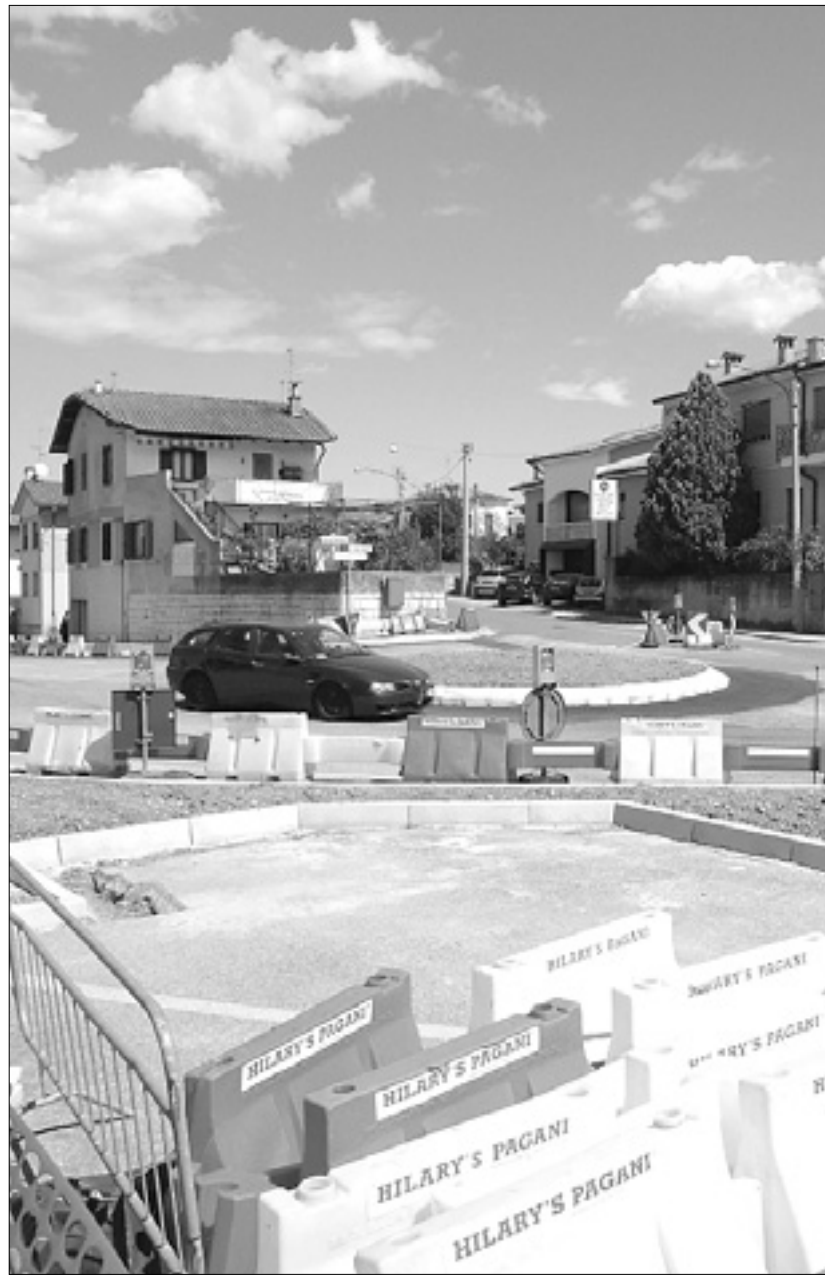
Nedokončano štandreško krožišče
