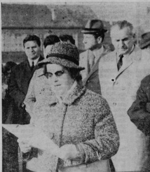
Torek 17. novembra. Slavnostni začetek del pri gradnji posebne osnovne šole v Celju. Predsednica občinske skupščine Olga Vrabčeva bere besedilo spominke listine, ki jo je zatem vgradila v temelj nove šole.
