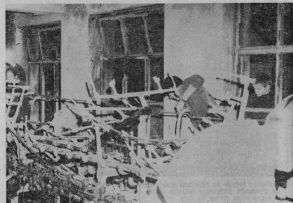
Delavci Juteksa so nemudoma začeli s čiščenjem posledic nedavnega požara. Prav zaradi prisebnosti delavcev in gasilcev je škoda tokrat manjša. Posnetek prikazuje ostanke zgorelih naprav. Foto: B. S.
