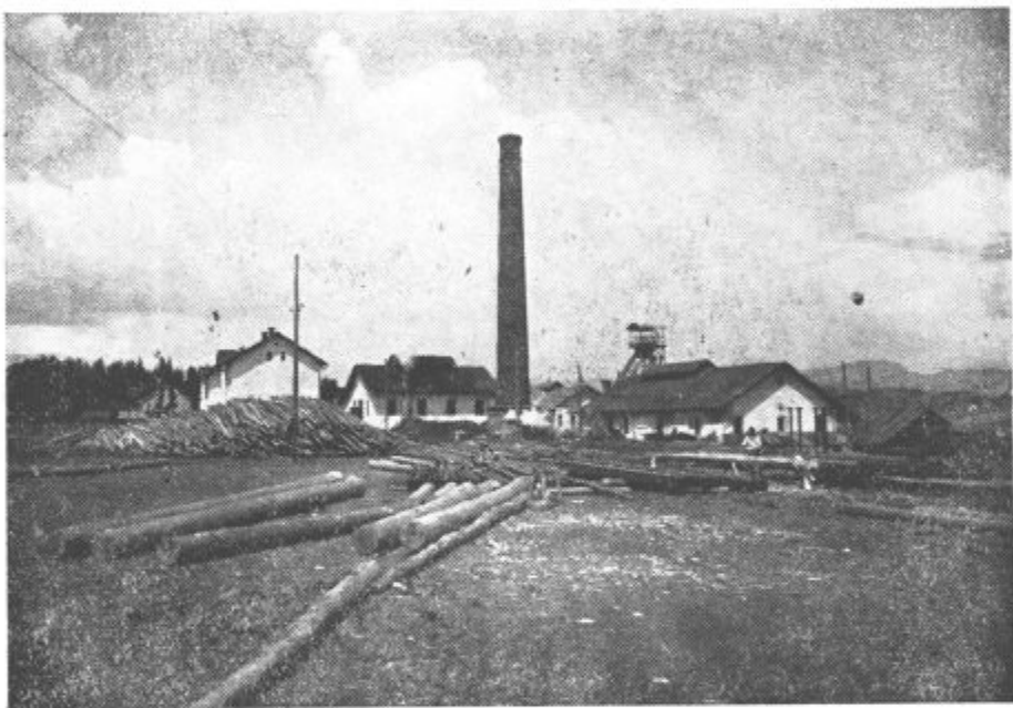
Stari jašek rudnika Velenje je nekaj izgleдал tako kot prikazuje slika. Danes je na tem mestu že polno novih stavb, od katerih se ena ravno v tem času gradi. To bo nova moderna lamparna, ki bo vezala nove rudniške kopalnice in tehnično upravo, tako da bodo vsa poslopja vezana med seboj.
