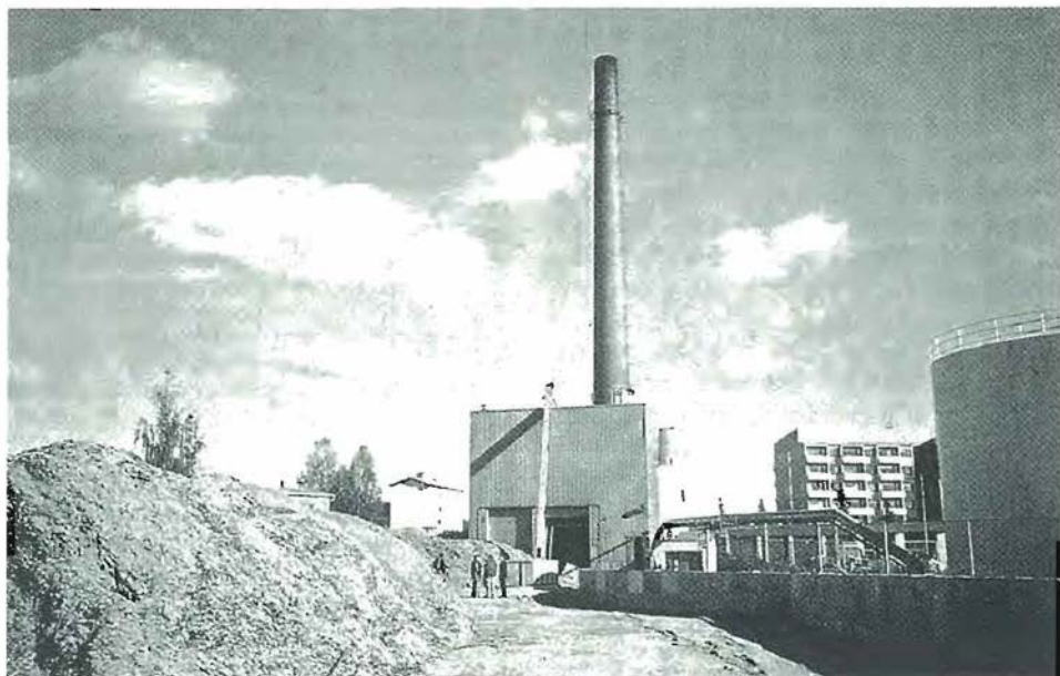
Sl. 1: Sodobna toplana na sekance iz sečnih ostankov (moč – 6,3 MW). Na Finskem obratuje več deset takšnih naprav. Vir: 586/1984.
