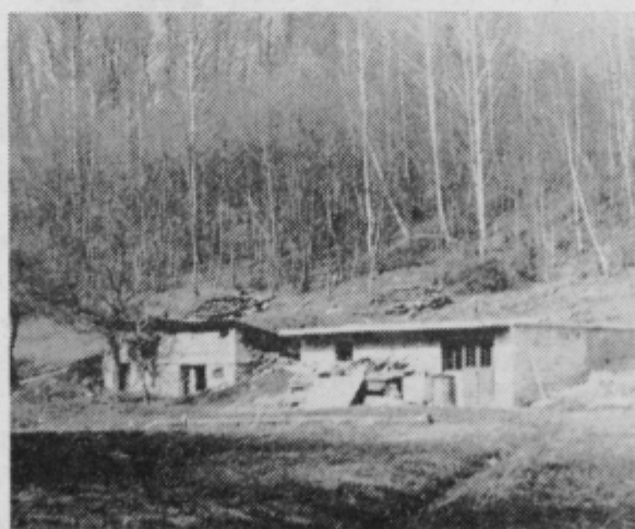
Na sliki so lepo vidni temelji nove hiše, ki sta jo gradila Ljubica in Rudi. Poleg nje pa je zgorelo gospodarsko poslopje 23. marca.
