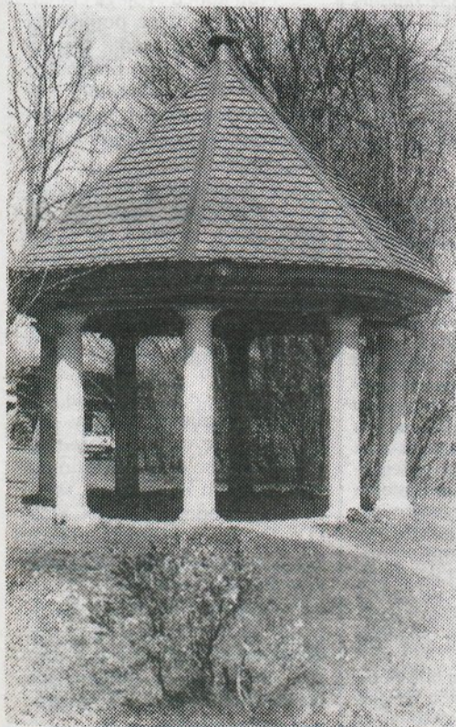
Grajski paviljon v Češeniku z obnovljeno streho
