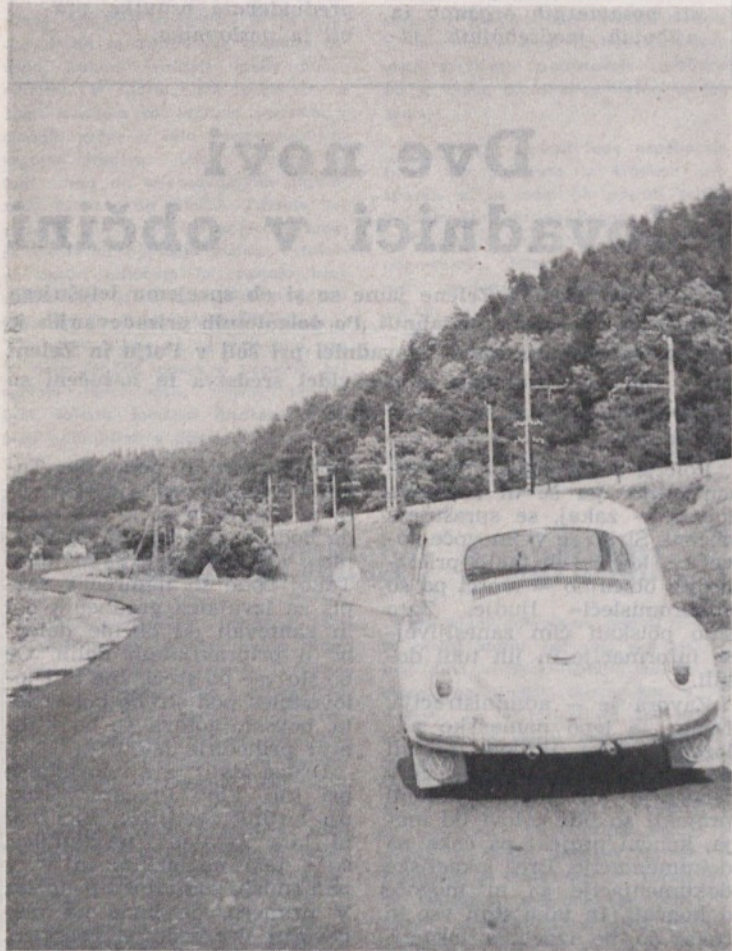
Tudi cesta od zaloškega mostu do podvoza v Podgradu je dobila asfaltno prevleko
