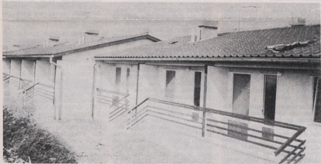
V Zalogu so zgradili novo stanovanjsko sosesko. Montažne hišice tipa Marles so zelo funkcionalne in dokaj udobne pa tudi cene so dostopne za žep povprečnega občana. Več o tem lahko preberete na tretji strani.
